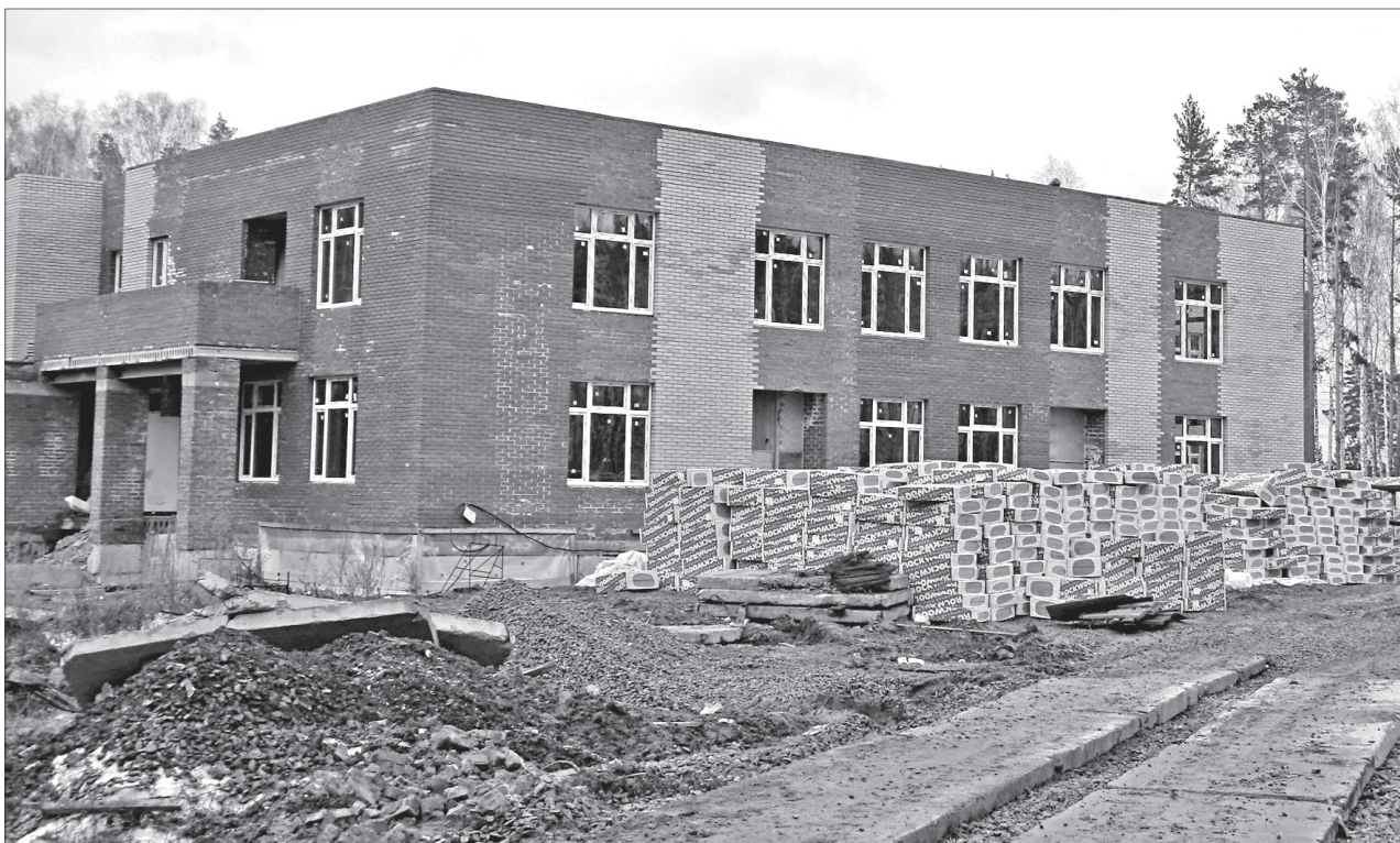
Одним из ключевых объектов, входящих в Перечень мероприятий на 2017 год, является детский сад №50 на въезде в город. Строительные работы в ДОУ производит ООО «ЖилСтрой» (исполнительный директор Сергей АЛЕКСАНИН). Плановый срок окончания строительства – 31 августа с.г.
