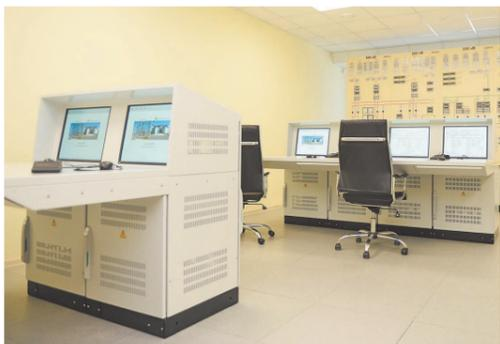
тренажёров, в их числе – уникальный полномасштабный тренажёр блочного пункта управления энергоблоком с реактором БН-800, на котором оперативный персонал может отрабатывать любые режимы энергоблока: нормальной эксплуатации, включая режимы пуска и останова, нарушения нормальной эксплуатации и различные их сочетания.
