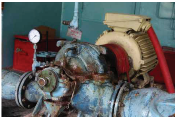
Рисунок 4. Насосное оборудование ВНС-4 Рисунок
