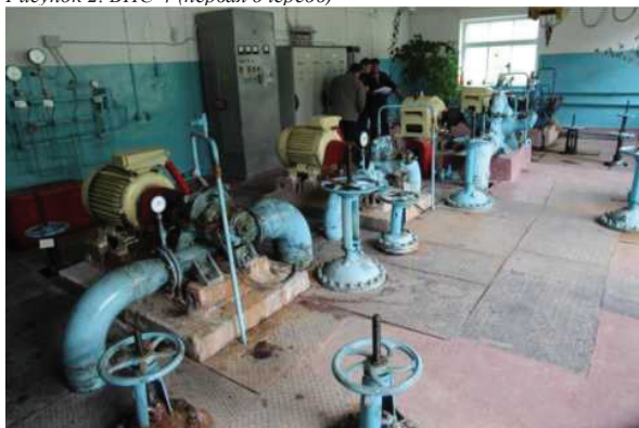
5. Насосное оборудование ВНС-4
