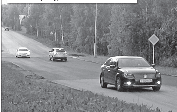
В выходные проведен ремонт дорожного полотна на ул. Курчатова.
