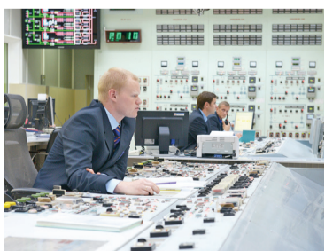
подготовительные работы к среднему ремонту блока, который запланирован на август 2020 года. Во время ремонта, так же как и при эксплуатации энергоблоков, безусловный приоритет отдается безопасности. Четкая организация
