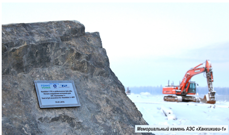
Строящаяся одноблочная атомная электростанция «Ханхикиви-1» в Финляндии с реактором ВВЭР-1200 по проекту АЭС-2006
