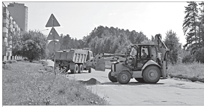
Ремонт дорог по улицам Курчатова, Кузнецова, Бажова выполнен на «атомные деньги».
