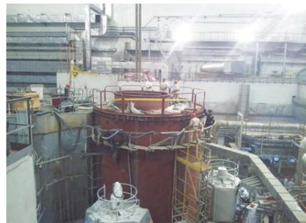
– выполнен монтаж защитного колпака, начат монтаж его крыши (на фото),
