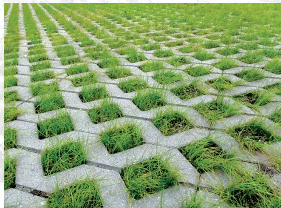
Устройство газонных решеток
