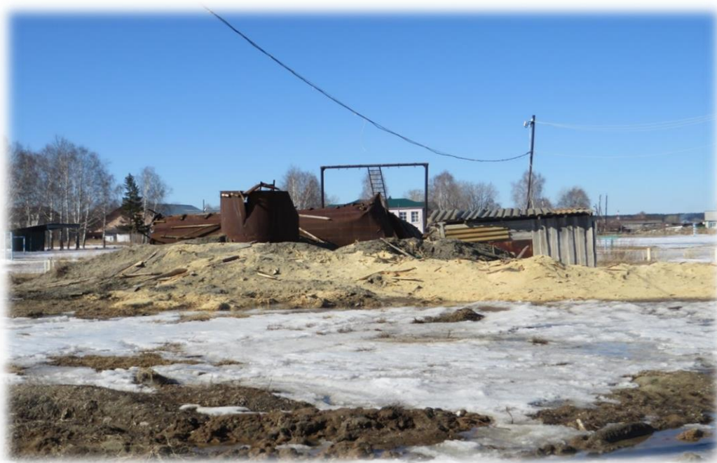
Рисунок 6. Скважина централизованного водоснабжения на ул. 70 лет Октября
