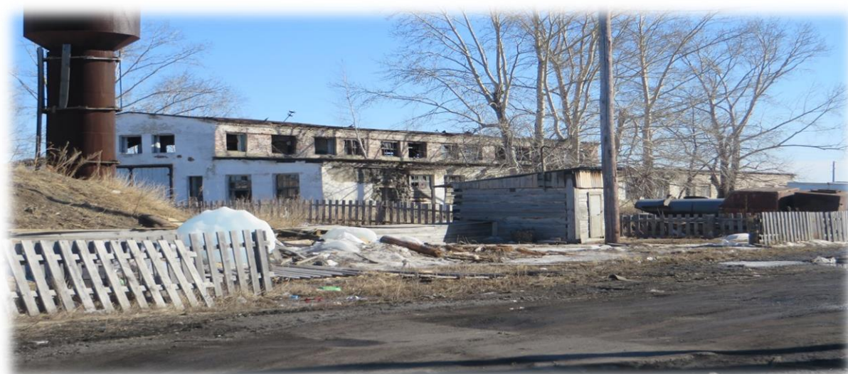
Рисунок 4. Скважина централизованного водоснабжения на ул. Гагарина, 94
