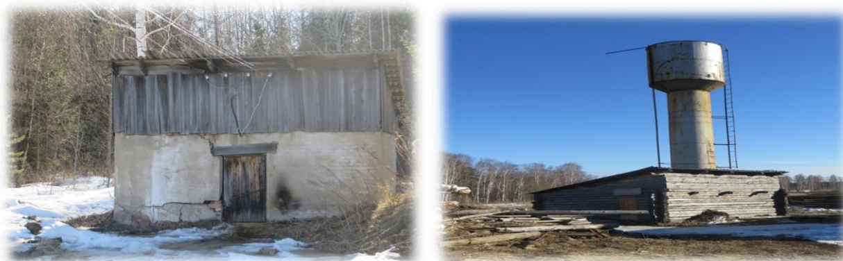
Рисунок 8. Скважина централизованного водоснабжения с.Мугай
