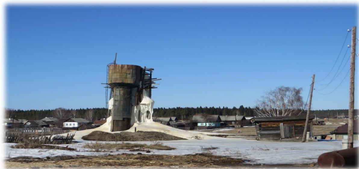
Рисунок 3. Скважина централизованного водоснабжения на ул. Профсоюзная, 1
