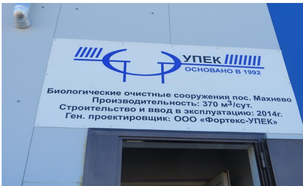
Рисунок 4. Очистные сооружения ООО «Фортекс-УПЕК»
