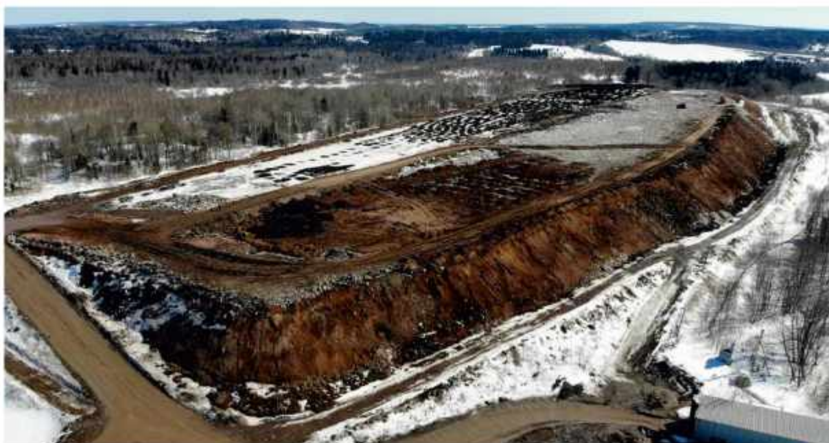
Рис. 13. Полигон ТКО г. Краснокамска
