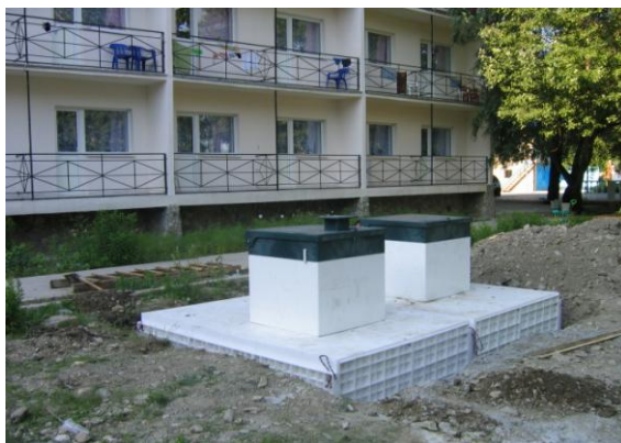
Рисунок 23 - Локальные очистные сооружения
