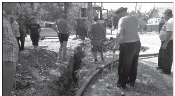
годность металлической трубы диаметром 50 мм на новую полипропиленовую трубу диаметром 110 мм. Работы по замене проводятся РЭУ Ивановский ПТП Кочубеевское ФЭП «Центральный» (Райводоканал) совместно с жителями домовладений, подключенных к данному участку водопровода, администрацией Ивановского сельсовета и МУП ЖКХ Ивановское. Протяженность заменяемого участка — 167 метров.
