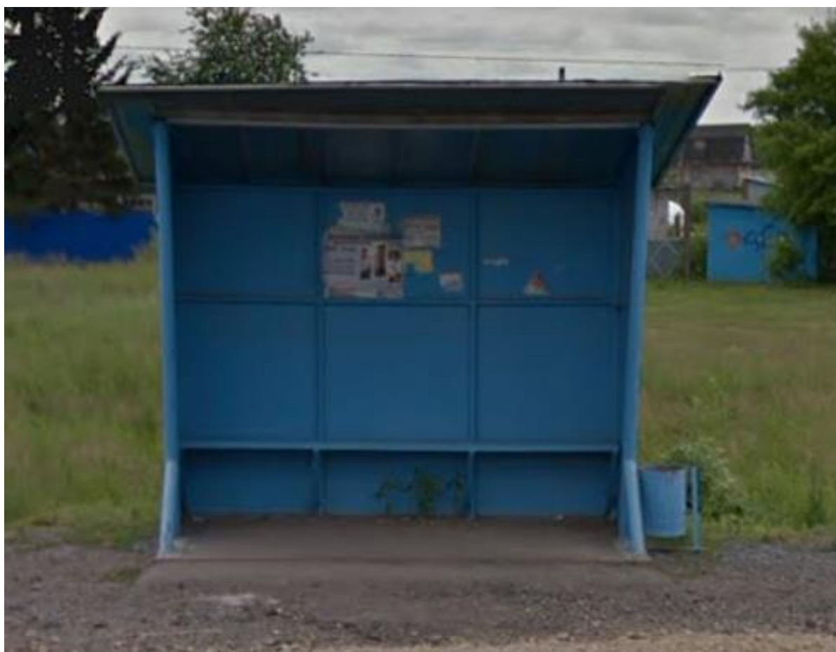
Рисунок 4 – Текущее состояние павильонов
