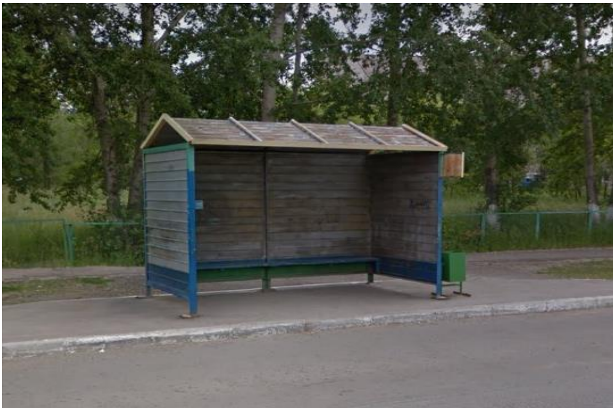
Рисунок 3 – Текущее состояние павильонов
