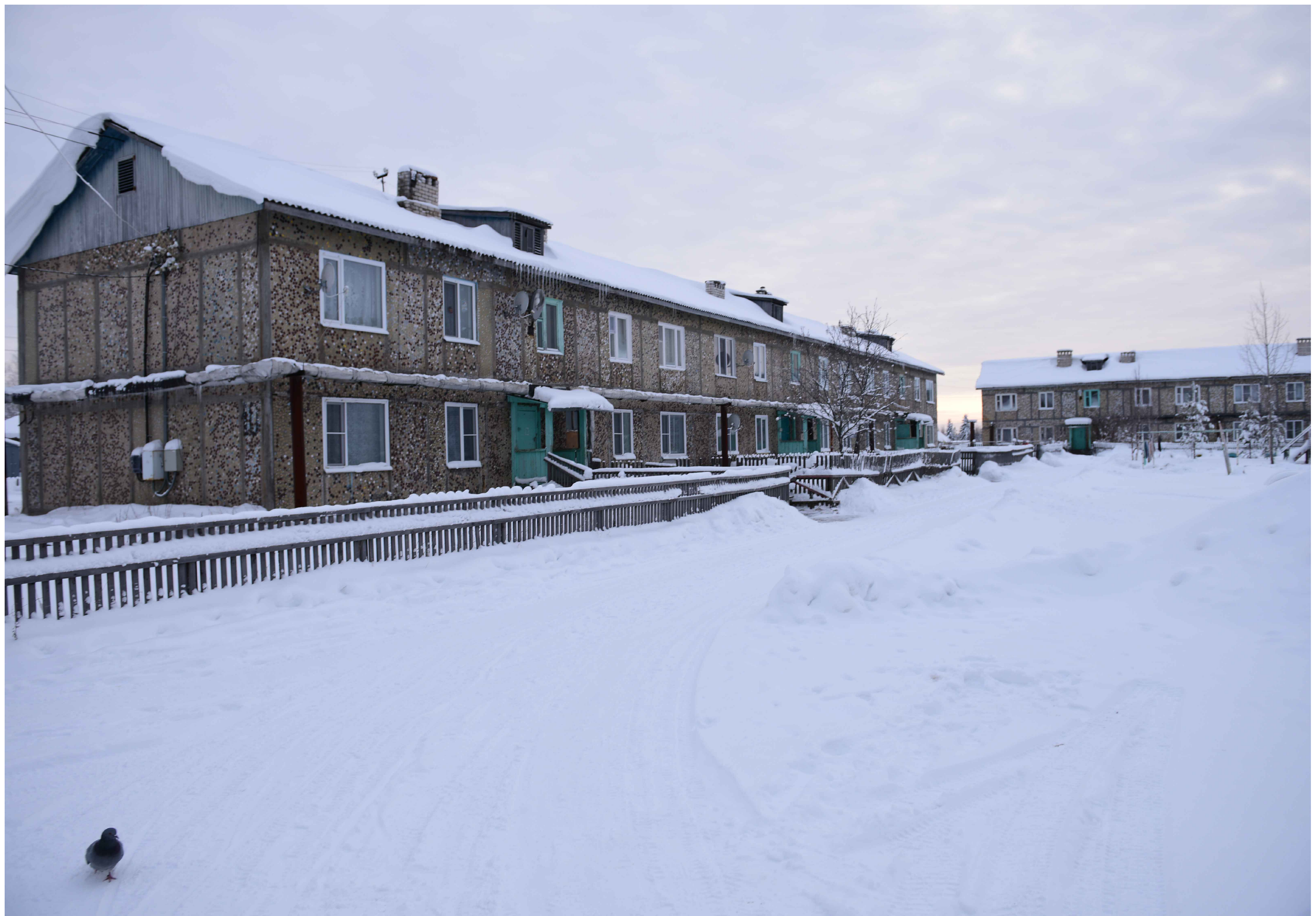
Фото 6. Общий вид площадки.
