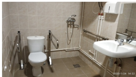
Ремонт на стадионе
