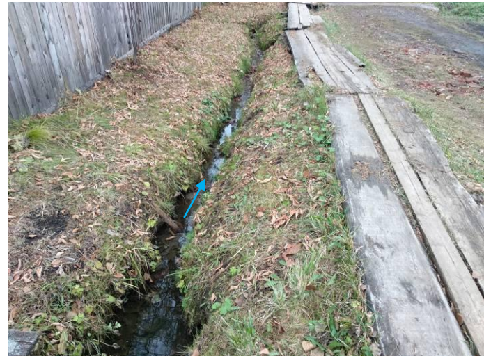
Фото 6. Водоотводная канава вдоль автодороги по ул. Карла Либнехта
