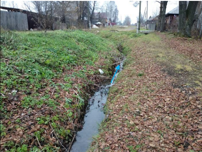
Фото 5. Канавы по дну ложбины местного стока №2.
