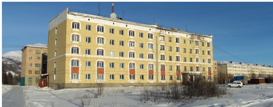
Утепление цоколя, окон, фасадов.
