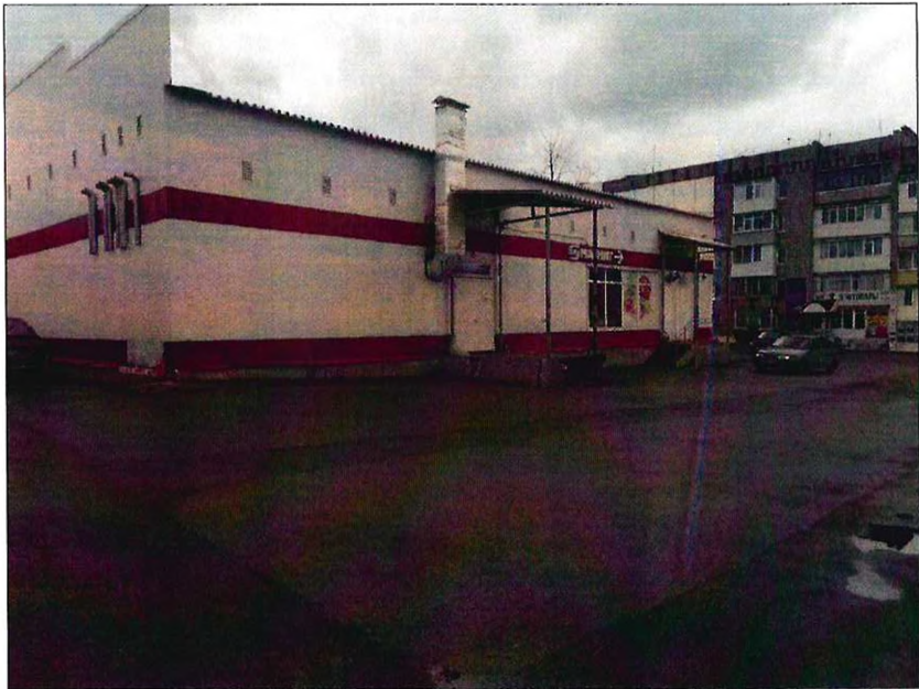
Существующее состояние бокового фасада (фотофиксация)
