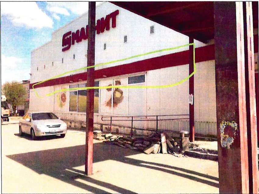
Существующее состояние главного фасада (фотофиксация)
