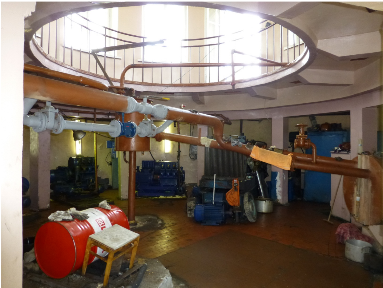
Фото 3. Памятник природы «Тальский». Оборудование для перекачки термоминеральной воды.
