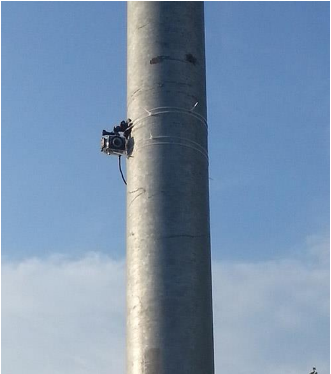
Рисунок 5 – Монтаж видеокамеры на столб линии электроосвещения
