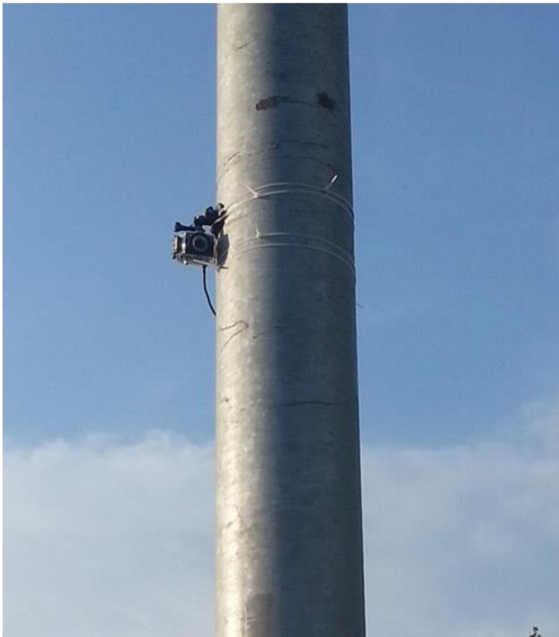
Рисунок 5 – Монтаж видеокамеры на столб линии электроосвещения
