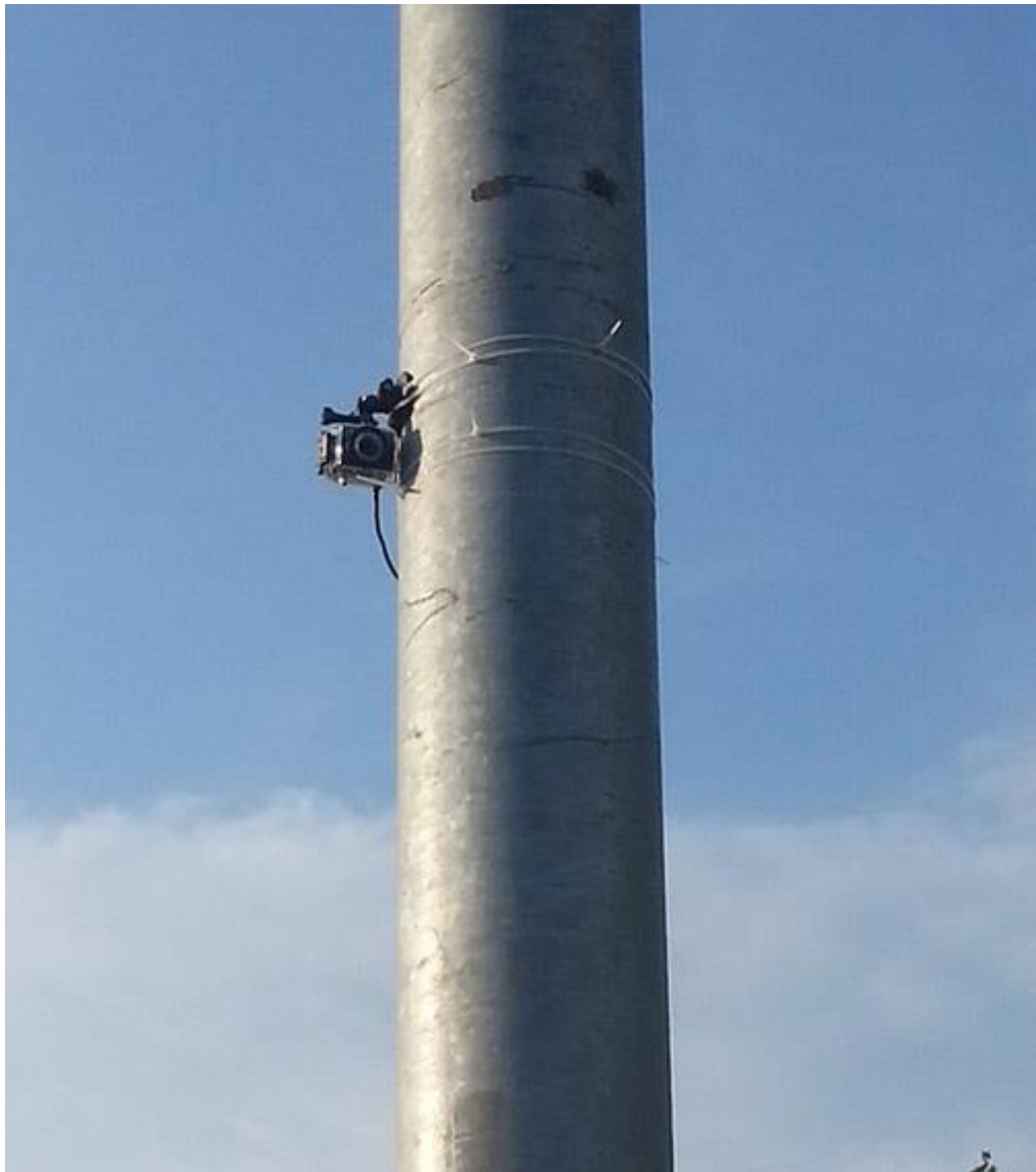
Рисунок 5 – Монтаж видеокамеры на столб линии электроосвещения
