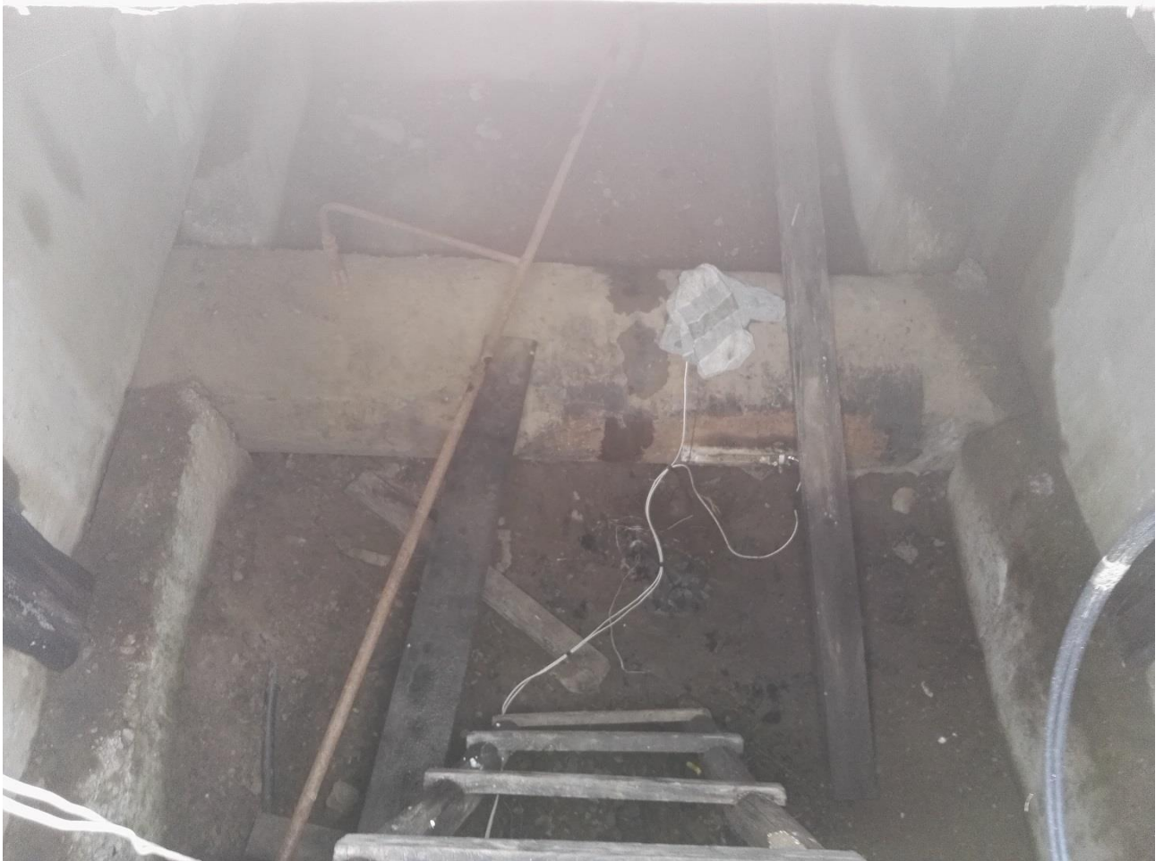
Рисунок 5 - Колодец с датчиками ультразвуковых расходомеров
