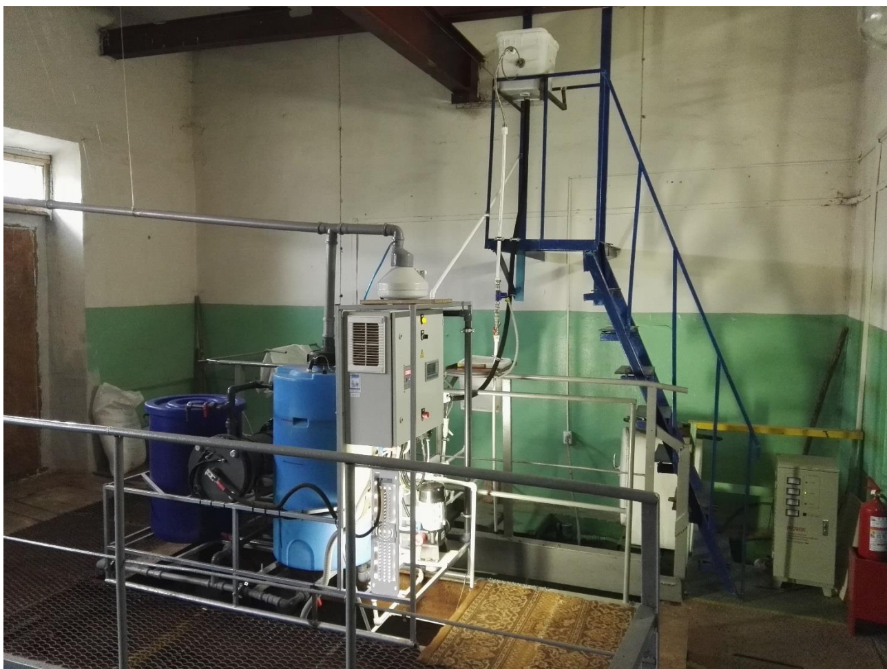
Рисунок 2 - Электролизная установка приготовления раствора гипохлорита
