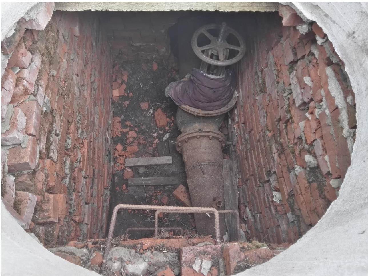
Рисунок 7 - Колодец на отводящем водоводе РЧВ № 1
