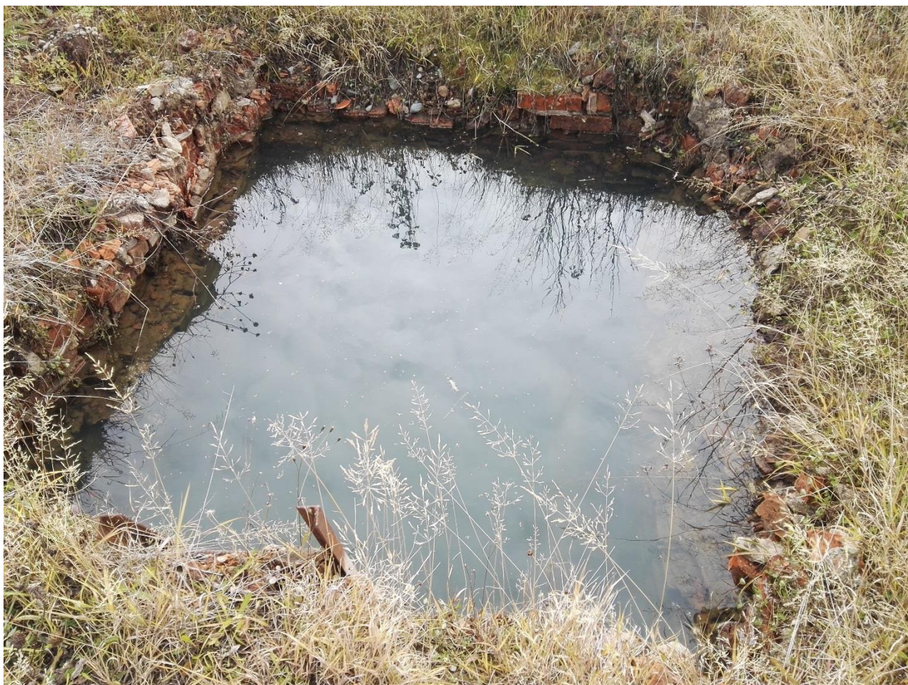
Рисунок 17 - Затопленная камера переключения на площадке РЧВ
