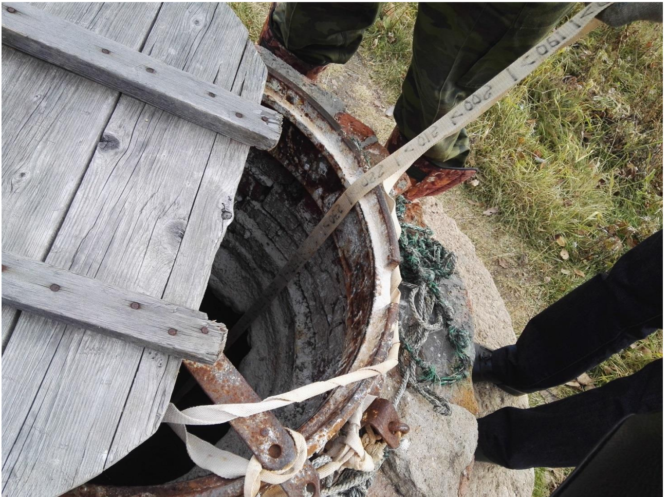
Рисунок 6 - Указатель уровня воды в резервуаре № 1, емкостью 1250 м 3
