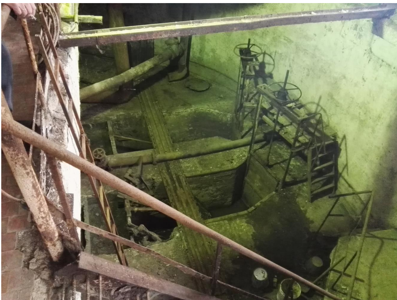
Рисунок 33 - Приемные галереи с механическими решетками
