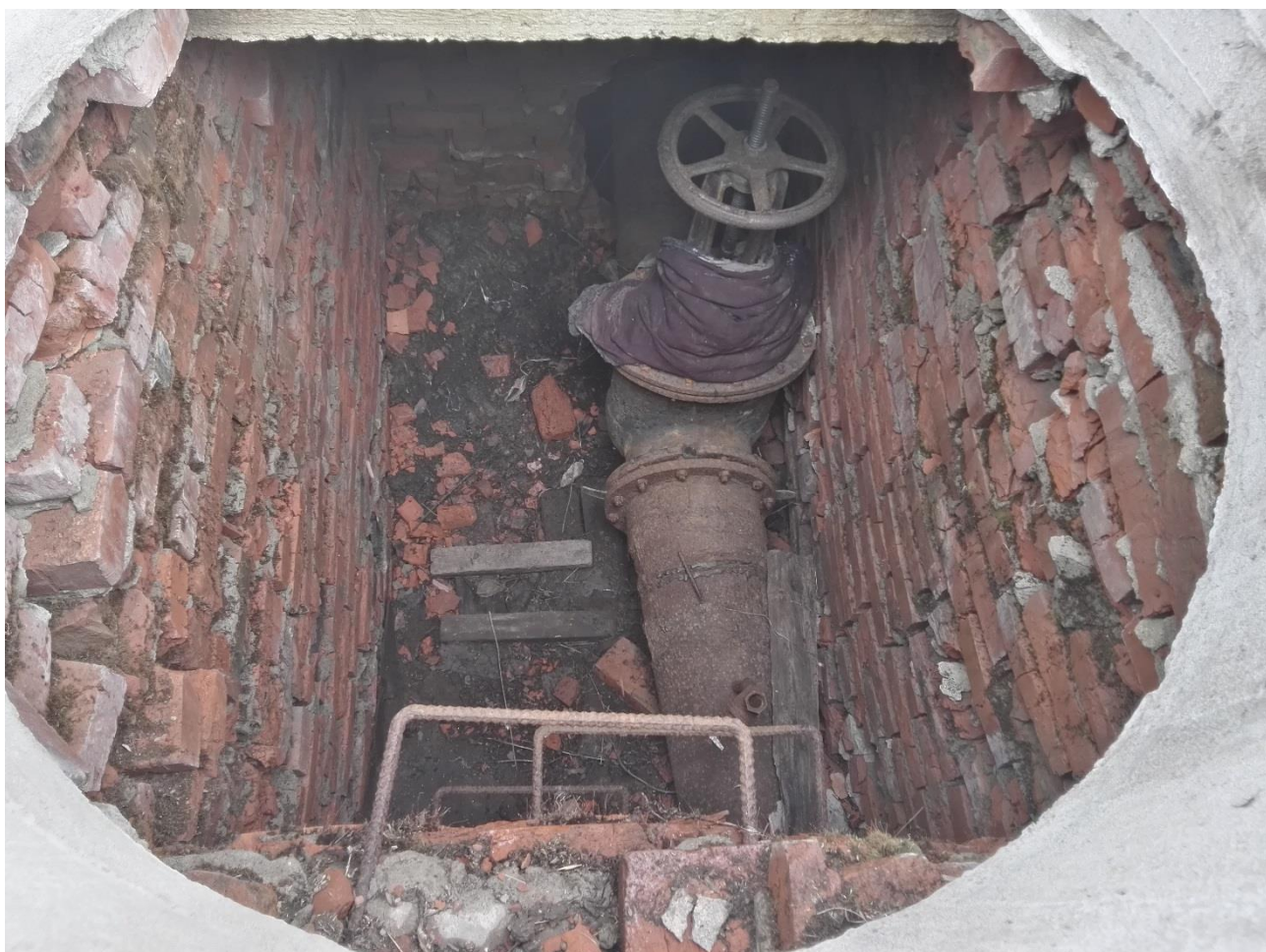
Рисунок 16 - Колодец на отводящем водоводе РЧВ №1
