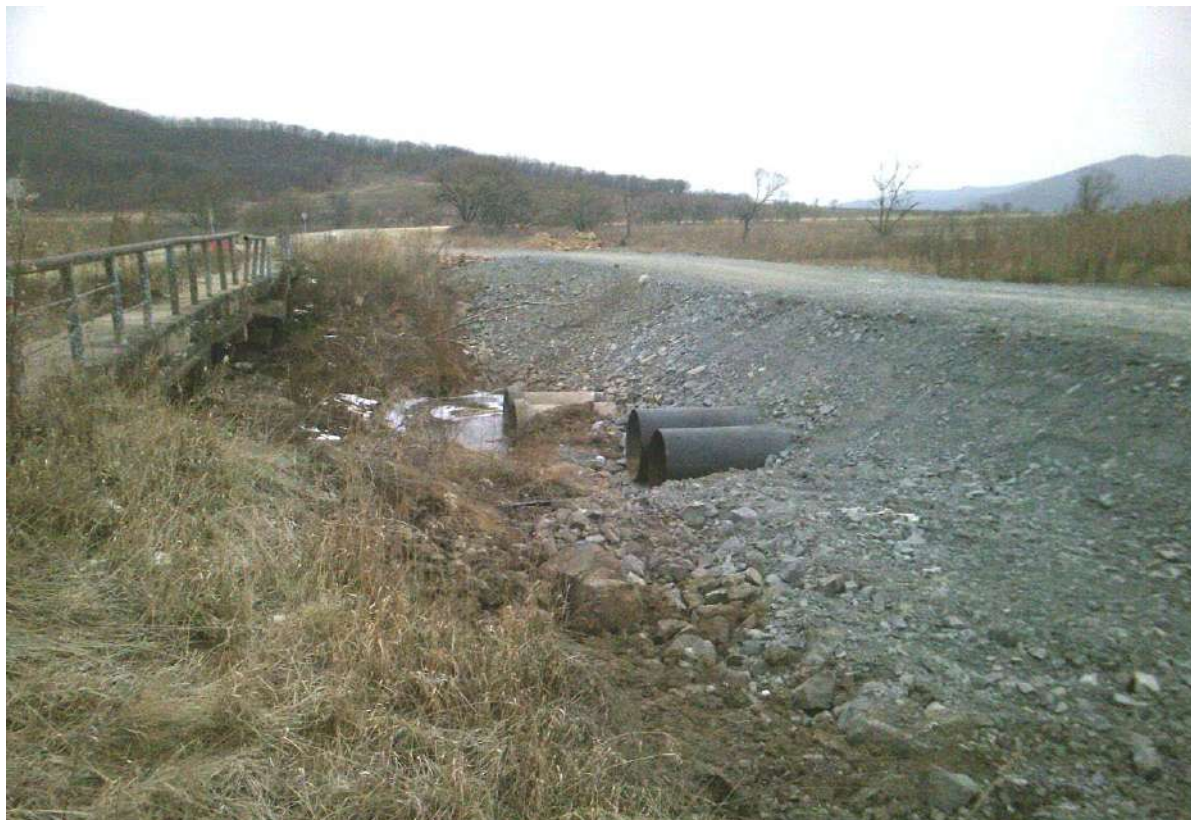
Фото 14. Дополнительные 2 металлические водопропускные трубы (диаметром 1 м) уложенные в насыпи объезда разрушенного моста через реку Кабанка осенью 2020 года. Вид в сторону левого склона долины (осень 2020 г).
