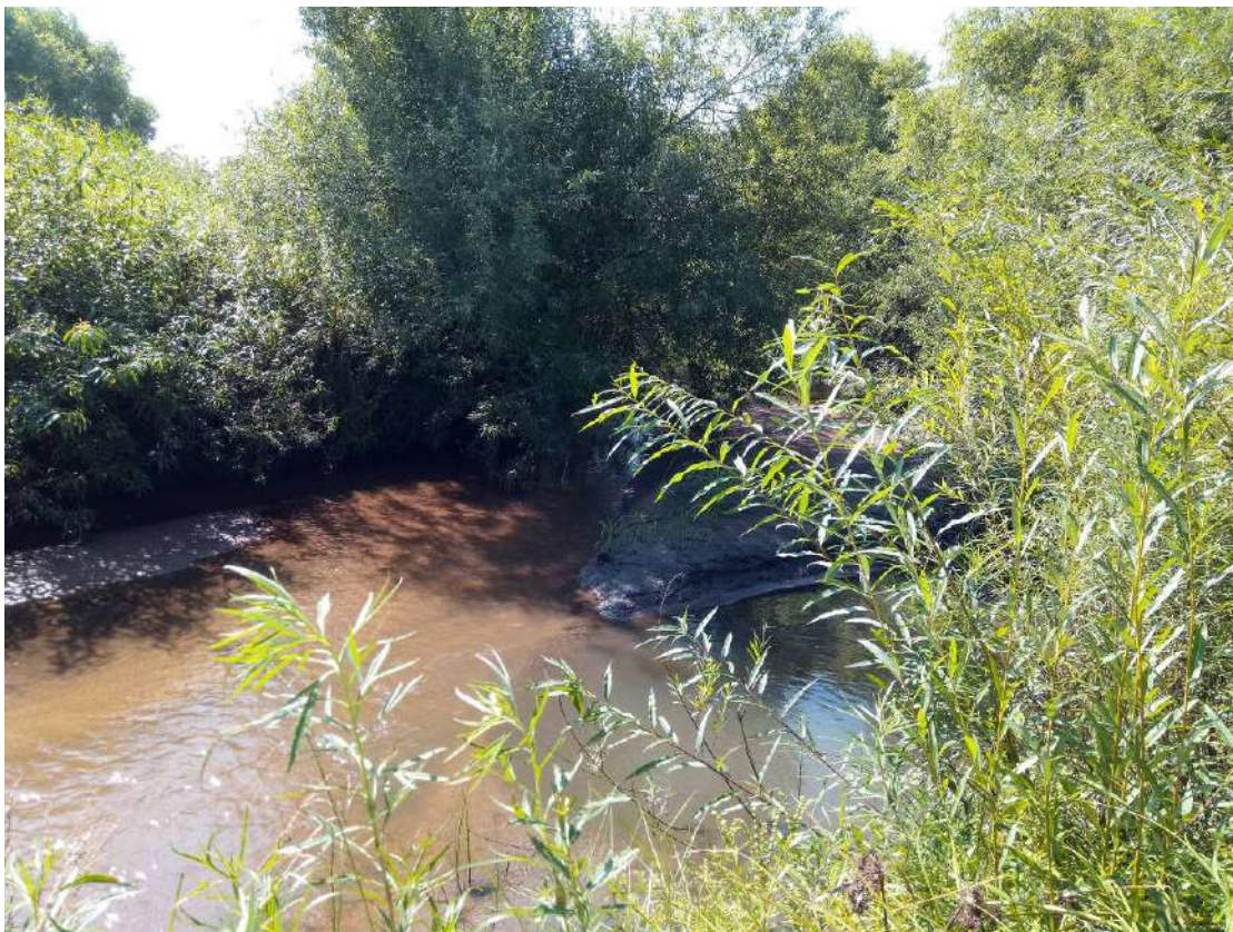
Фото 5. Русло реки Кабанка со стороны верхнего бьефа разрушенного моста. Вид вверх по течению (лето 2020 г).
