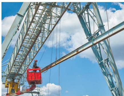
Козловой кран на погрузочной площадке отделения горячего цинкования ПСК пущен в работу с обновлённым монорельсом. Замена произведена в плановом порядке по причине износа конструкции. Работа выполнена силами цеха централизованного ремонта АО «Уралэлектромедь».
