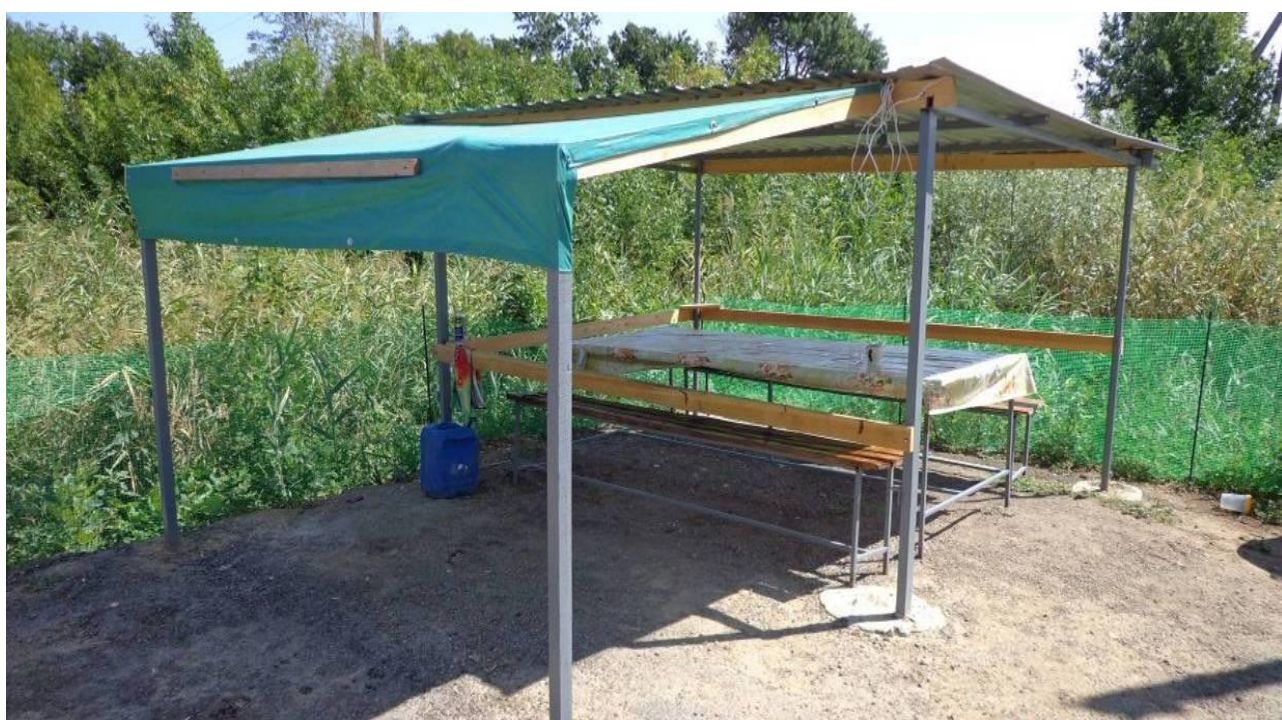
Рис. 43 – Сезонная придорожная ярмарка, федеральная автомобильная дорога М-4 «Дон», км 1250+050 слева, Выселковский район
