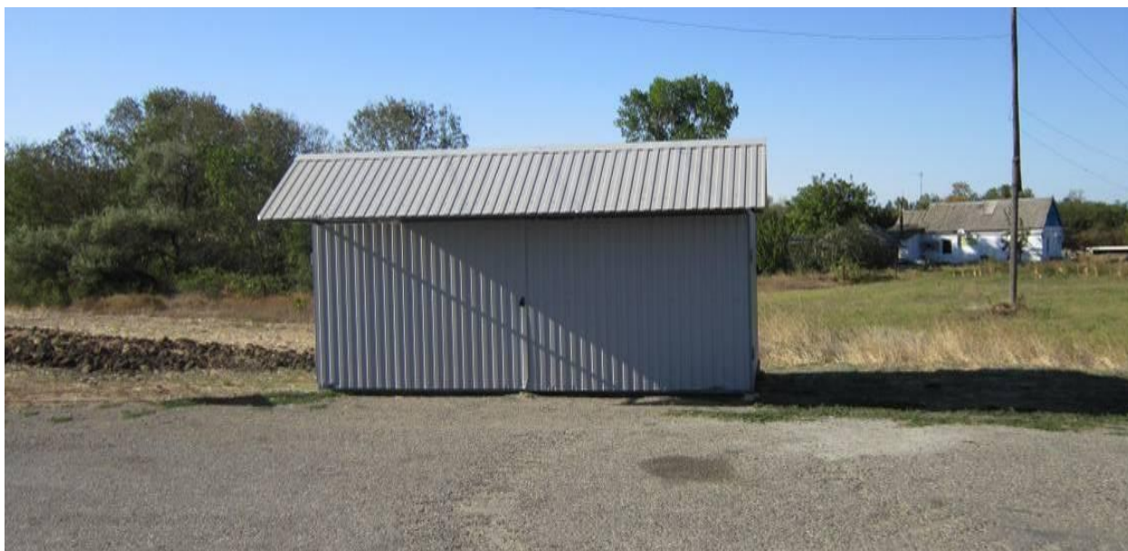
Рис. 60 – Автомобильная дорога «г. Краснодар – г. Ейск», км 213+582 справа, Щербиновский район
