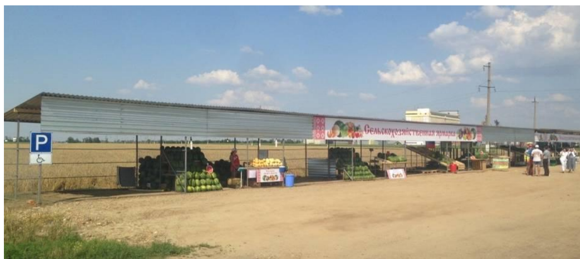
Рис. 20 – Автомобильная дорога «г. Темрюк – г. Краснодар – г. Кропоткин – граница Ставропольского края», км 290+825 справа, Тбилисский район
