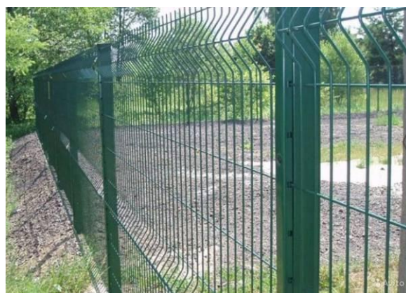
Сварные секционные металлические ограждения
