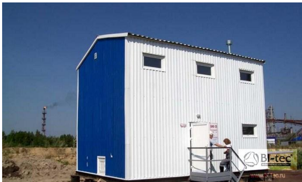
Рисунок 4 Внешний вид станции комплексной очистки сточных вод
