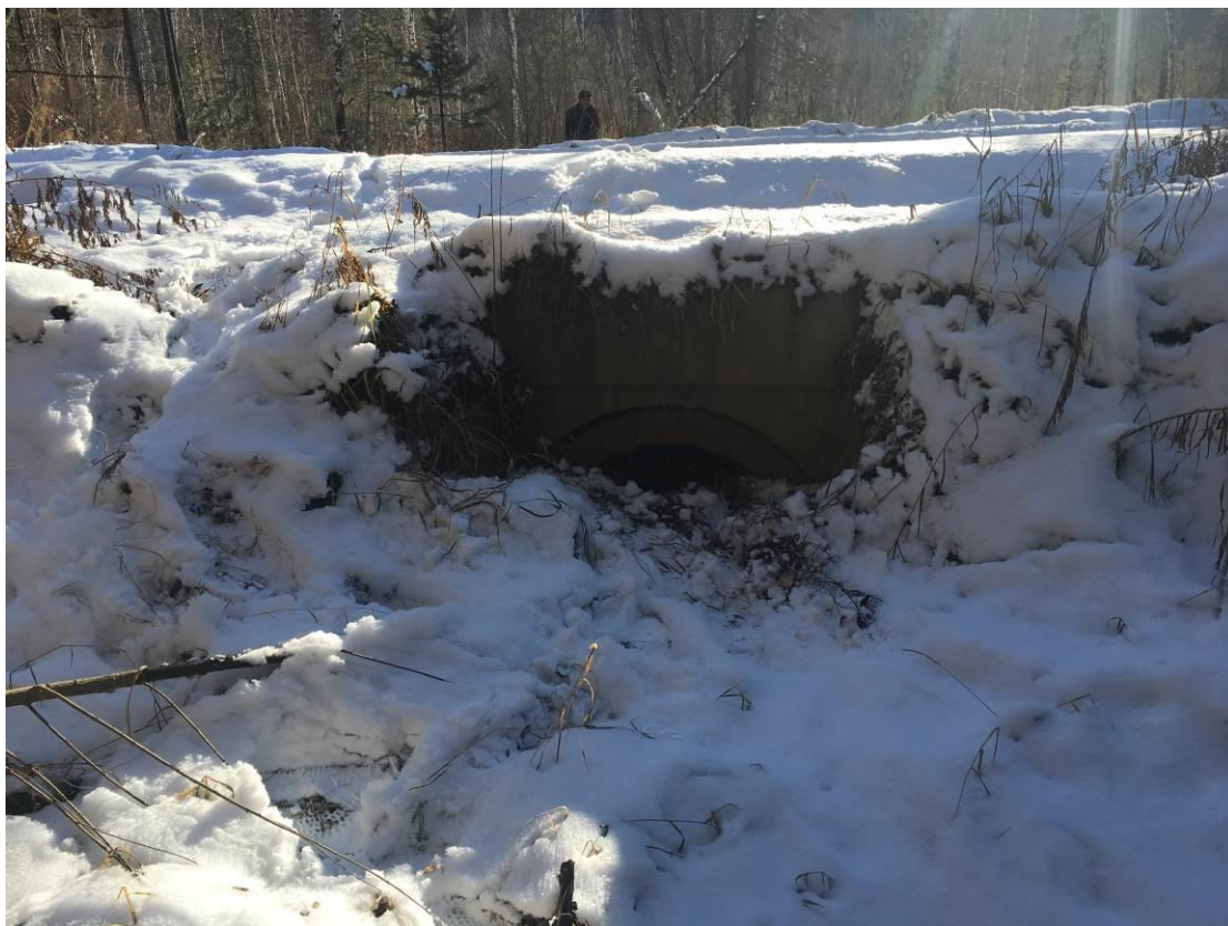
ПК 27+63 – Входное отверстие железобетонной трубы ( d = 1,0 м), в створе пересечения с логом;
