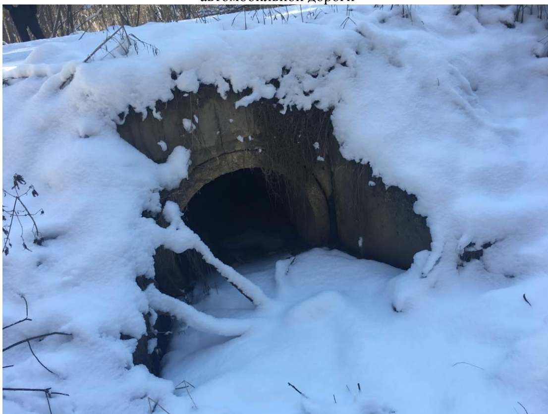
ПК 18+43 – Входное отверстие железобетонной трубы ( d = 1,0 м), в створе пересечения с неясновыраженным логом
