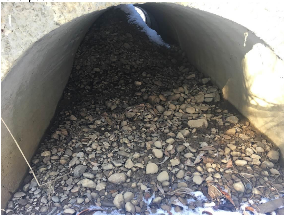
ПК 18+43 – Тело железобетонной трубы на выходе ( d = 1,0 м);
