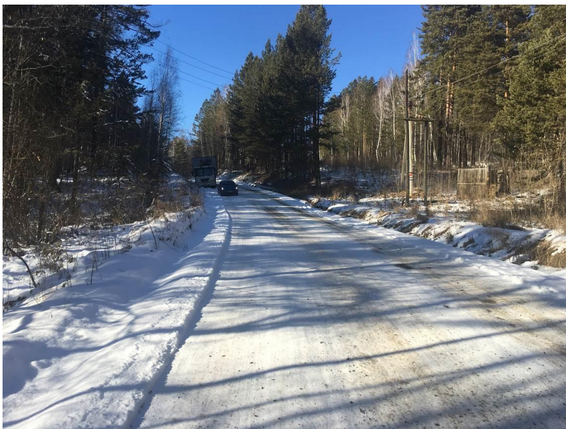
Автомобильная дорога на участке изысканий - ПК 11+00
