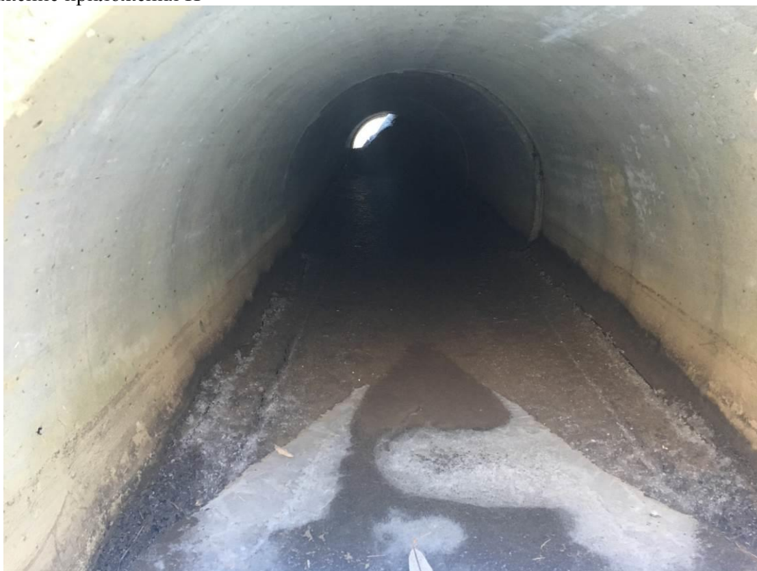
ПК 18+43 – Тело железобетонной трубы на входе ( d = 1,0 м);
