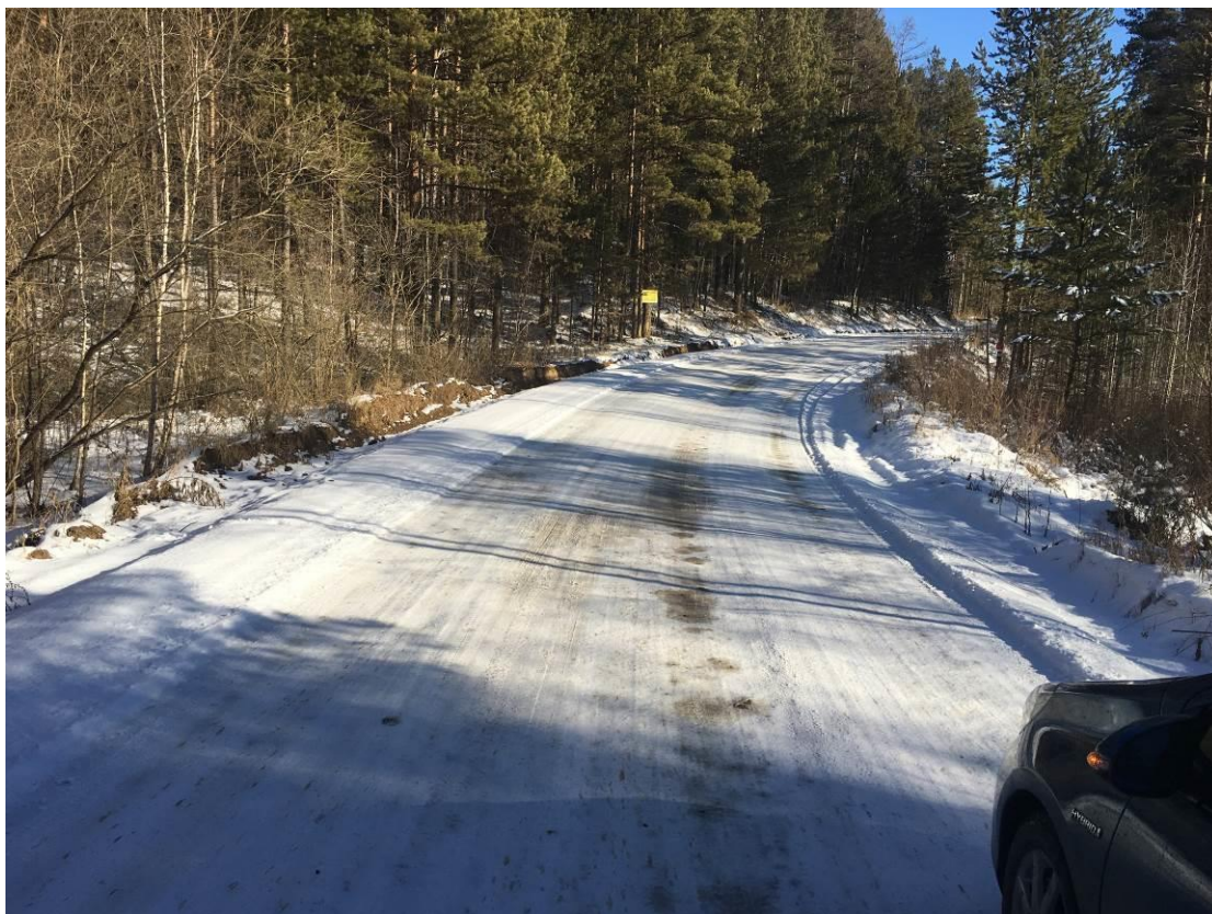
ПК 27+63 – Автомобильная дорога в створе пересечения с логом;
