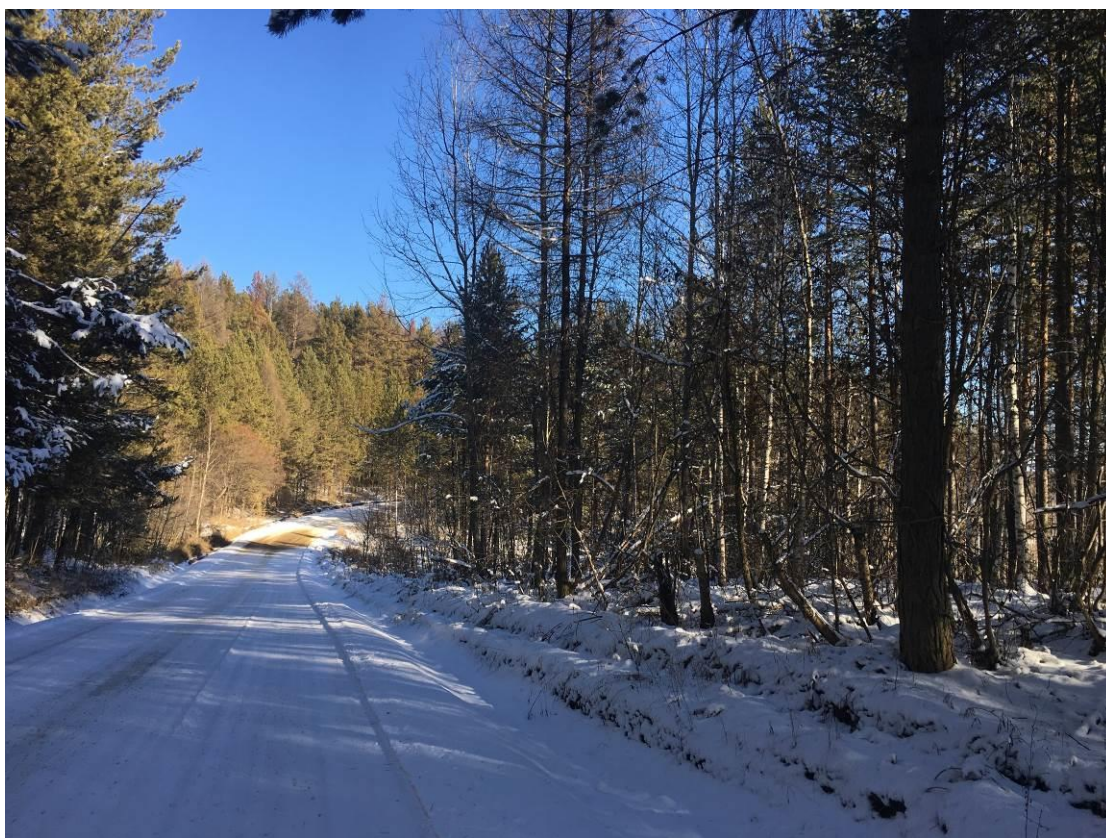
ПК 21+65 – Участок автомобильной дороги в створе пересечения с логом
