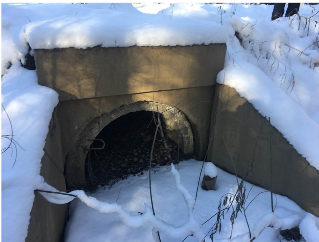
ПК 18+43 – Выходное отверстие железобетонной трубы ( d = 1,0 м), в створе пересечения с неясновыраженным логом
