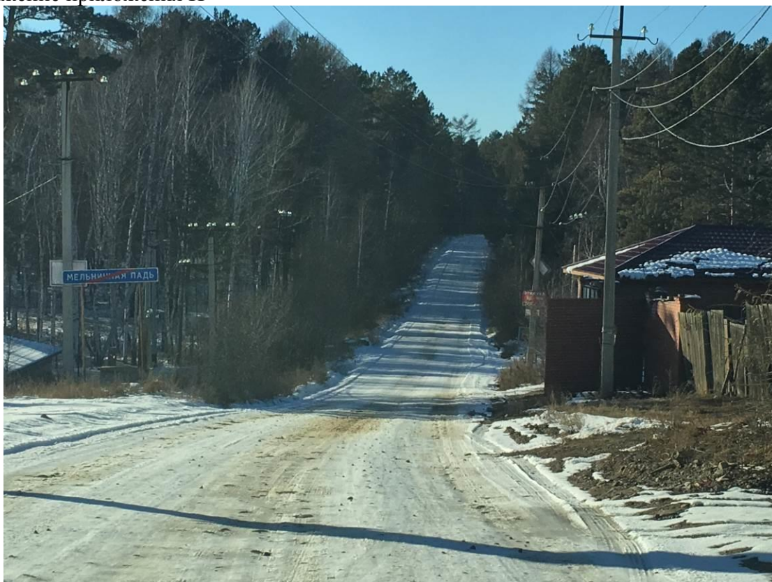
ПК 42+50 – Лог в створе пересечения с трассой проектируемой автомобильной дороги
