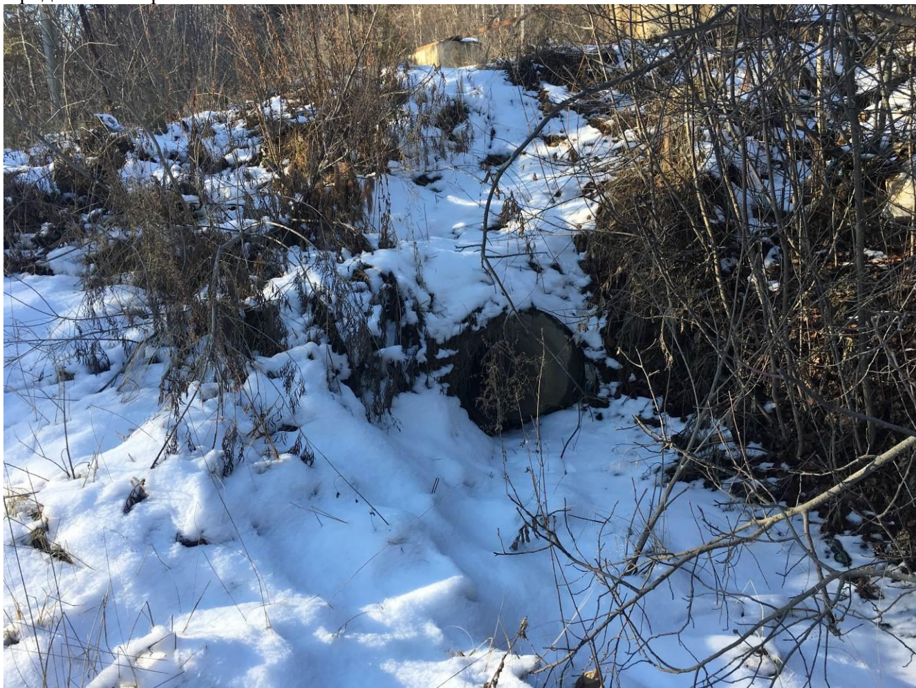
ПК 42+75 – Железобетонная труба на съезде, d=0,6 м.
