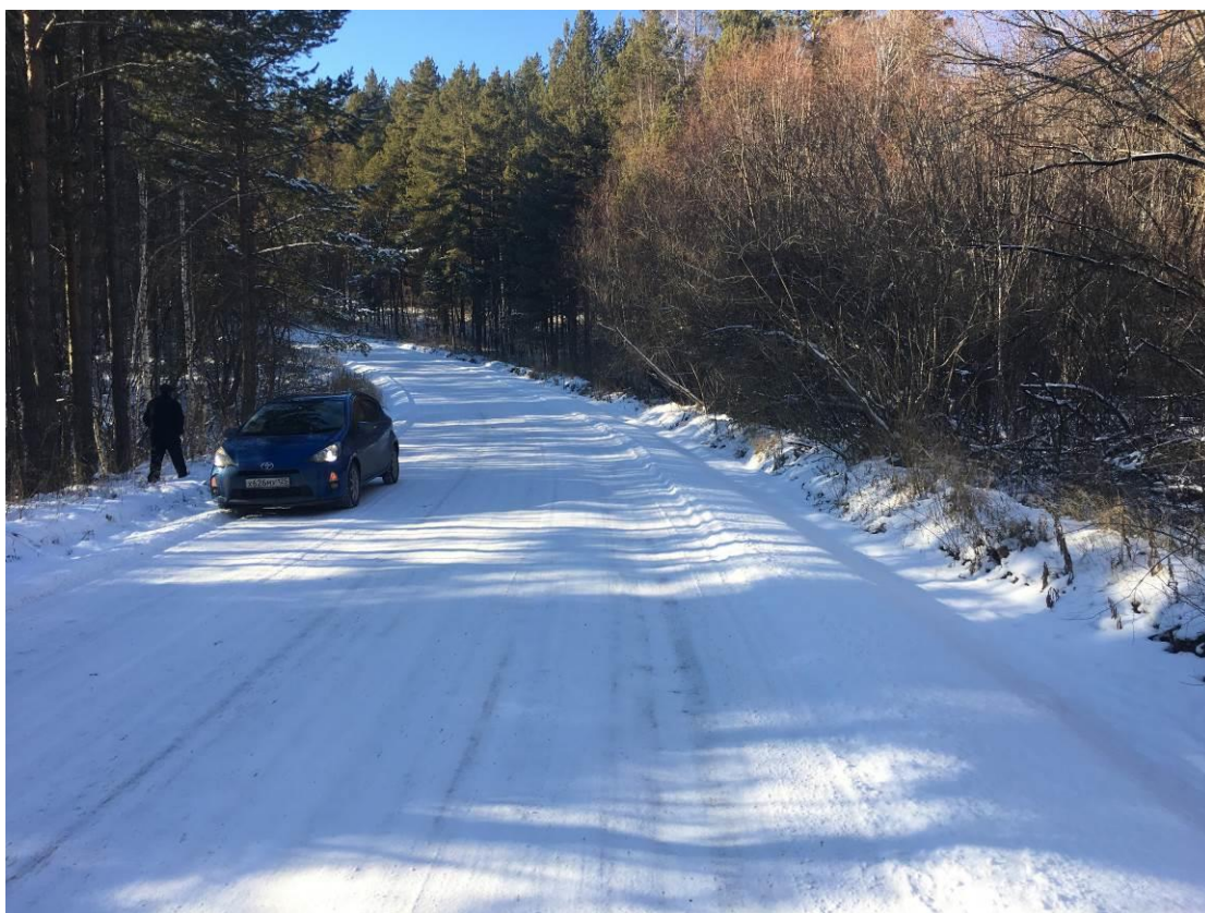
ПК 35+01 – Автомобильная дорога в створе пересечения с логом
