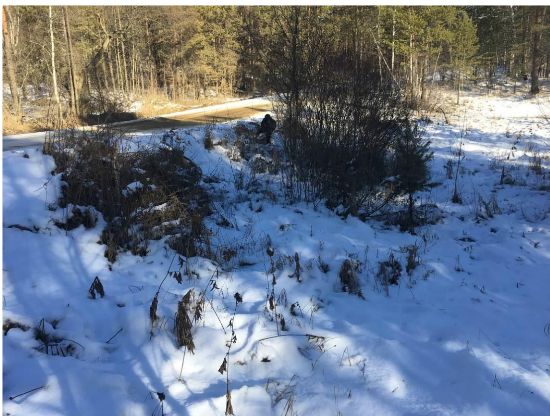
ПК 21+65 – Ситуация ниже створа пересечения с логом;
