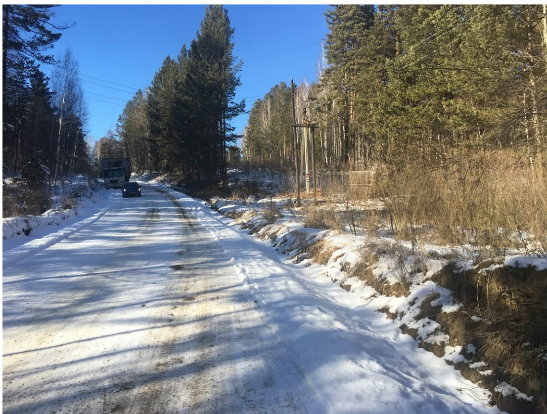
Автомобильная дорога на участке пересечения с пониженной частью односкатного водосбора в створе ПК 12+25;
