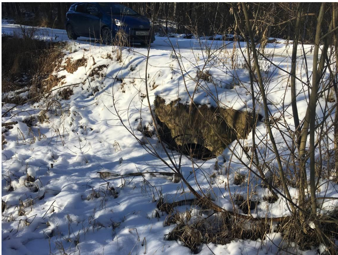
ПК 27+63 – Выходное отверстие железобетонной трубы ( d = 1,0 м), в створе пересечения с логом;
