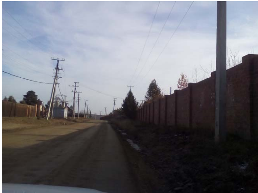
Рисунок 2- участок изысканий, прохождение трассы по поселку
