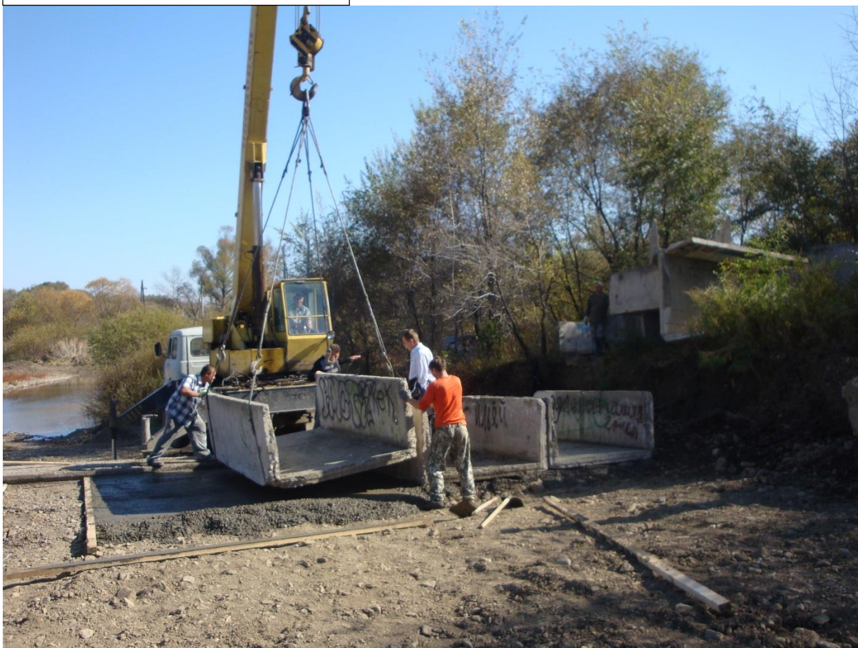
Ремонт подруслового водозабора
