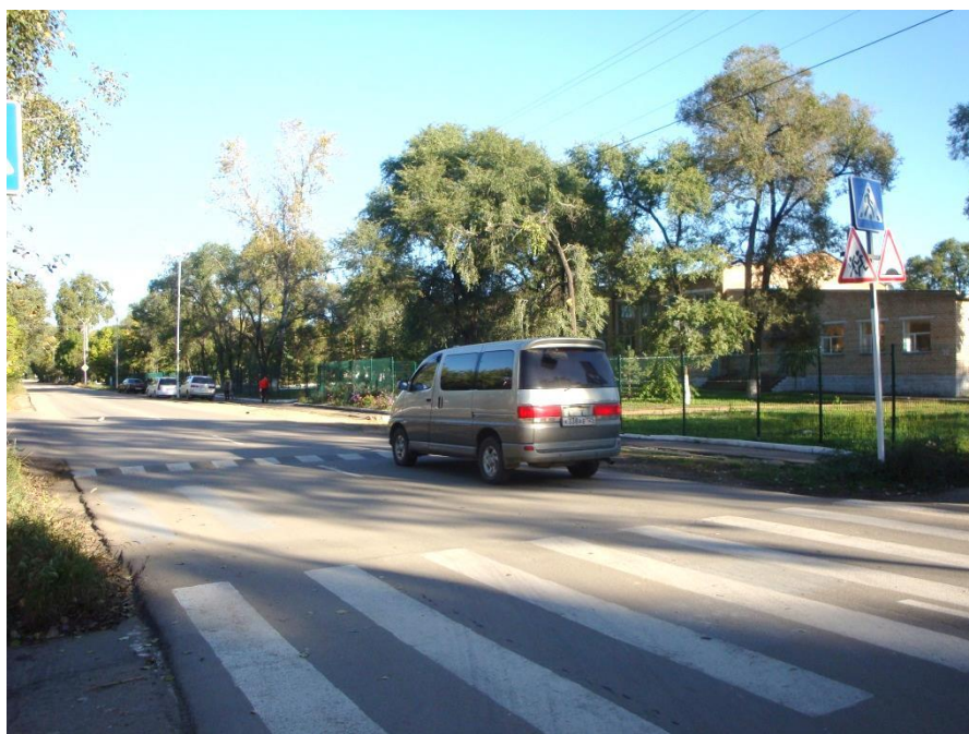
Новый асфальт и дорожная разметка по ул.Кирова
