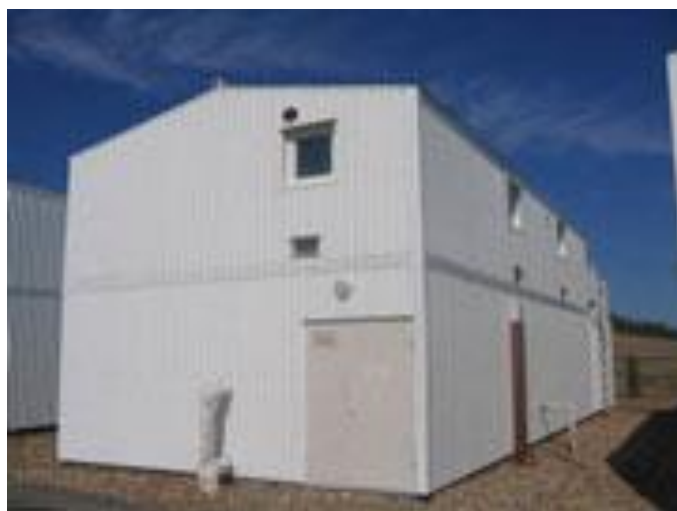
Рис. 9 Внешний вид очистных сооружений «Биоресурс»
