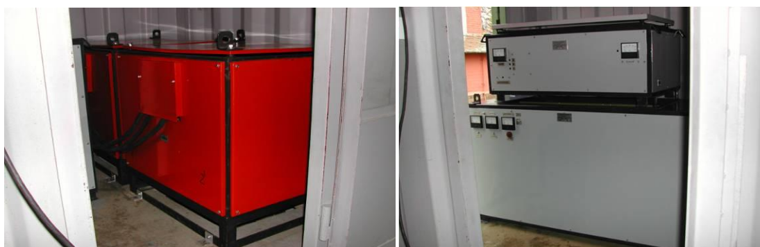
Рисунок 3.6-7. Выпрямитель тока (слева) и электронный тиристорный коммутатор (справа)
