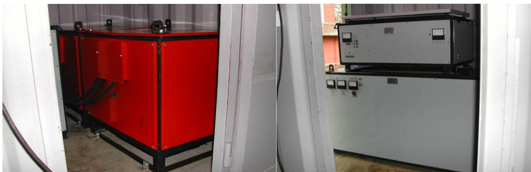
Рисунок 5.2-2. Выпрямитель тока (слева) и электронный тиристорный коммутатор (справа)
