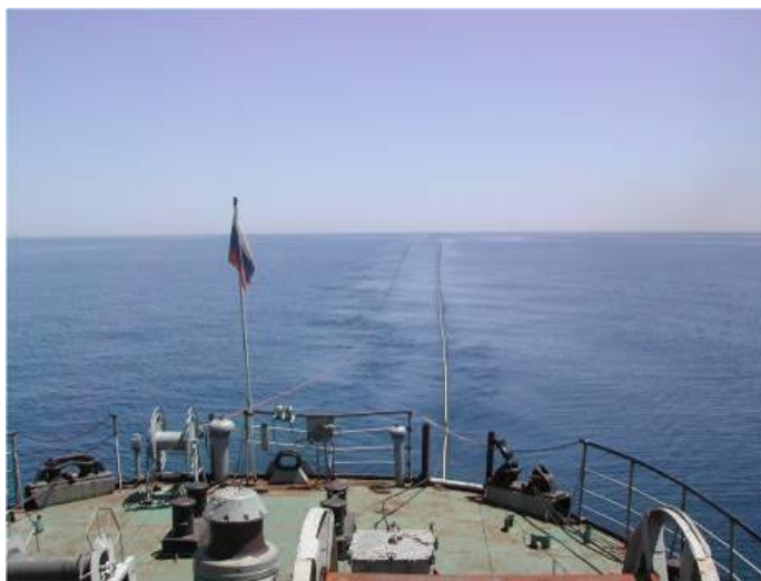
Рисунок 2.2-3. Буксировка приемной и питающей линий.
