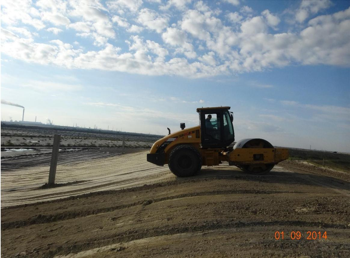
Фото 3 - Технология уплотнения грунтов на откосе
