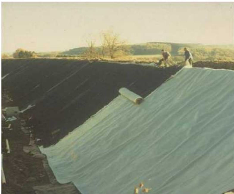
Рисунок 14 - Укладка «Гидромата» на откосе
