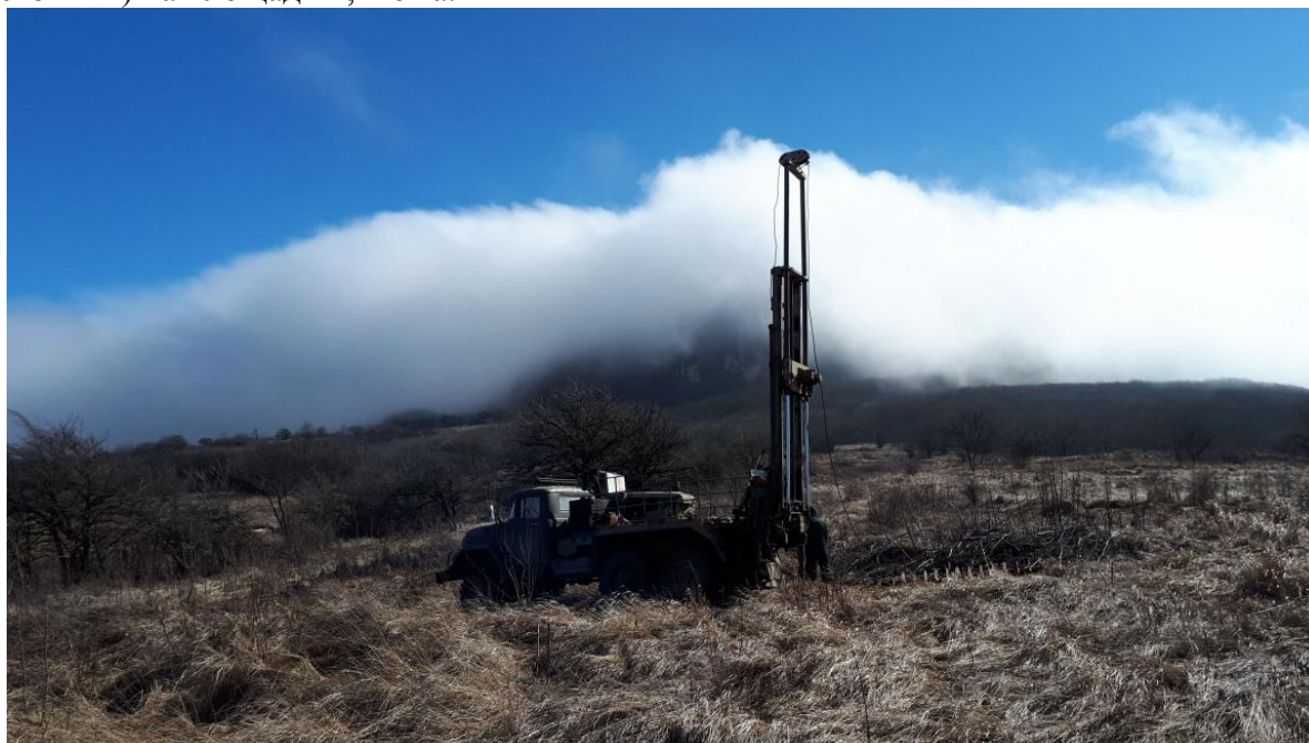
Существующее состояние закрытой городской свалки ТКО.
