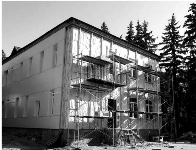
Капитальный ремонт здания ведется с опережением графика. Завершены работы по замене окон и кровли, ведется монтаж систем водоснабжения и отопления. Готовность фасада составляет более 90%. На обоих этажах продолжаются малярные работы.
