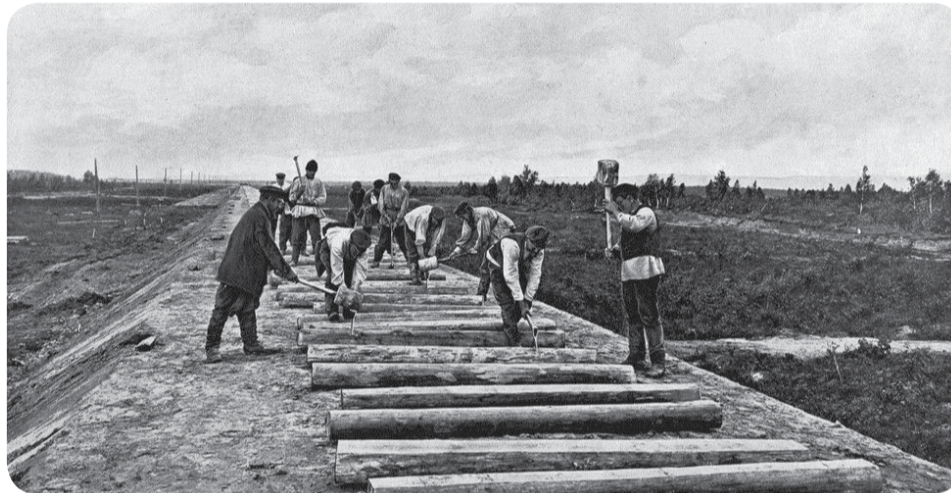
Возведение железнодорожной насыпи и укладка шпал. Конец XIX. Автор снимка неизвестен. Из архива автора
