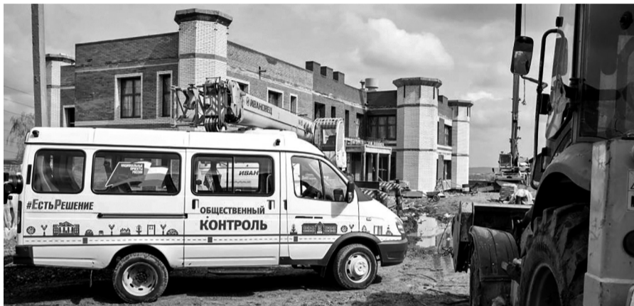
Строительство детского сада в поселке Маркова идет с опережением графика
