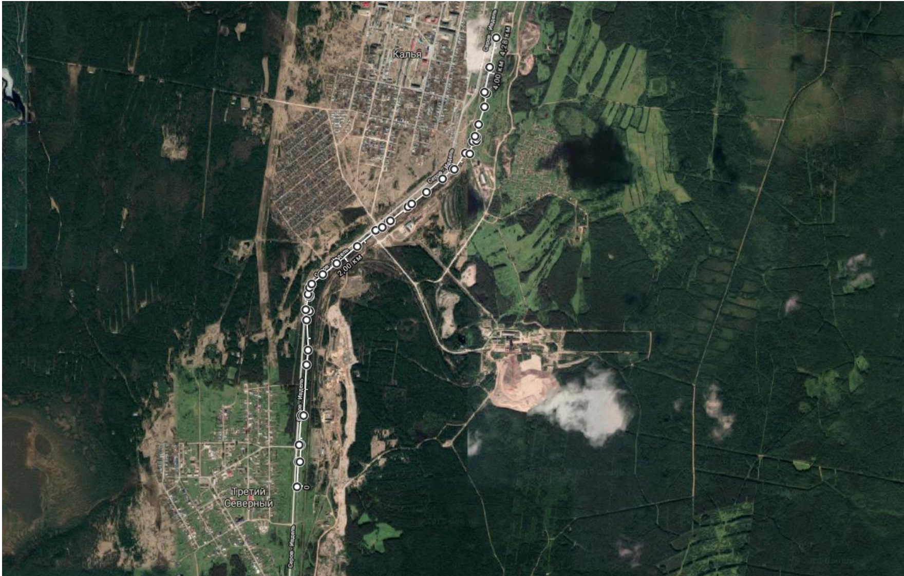
Рисунок 23. Выводимый из эксплуатации участок магистральной тепловой сети до п. Калья
