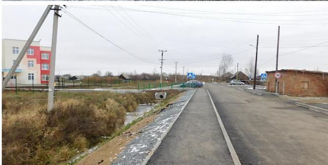
Другие работы, за исключением асфальтирования подъезда, ООО "Стройтранс" выполняло своими силами: подготовка и укладка дорожного полотна, установка бордюров, установка дорожных знаков, строительство пешеходного тротуара, укладка водопропускных труб. Сделаны и два подъезда к близлежащим домам. Все работы по строительству подъезда завершены и сданы.
