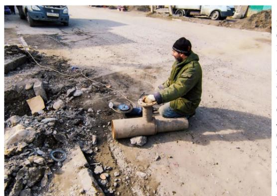
17 марта ОАО «Водоканалсервис» подключил вновь построенные сети водоснабжения к действующему водопроводу.
