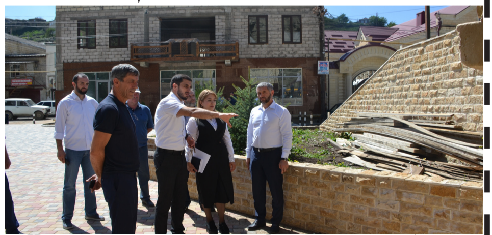
На снимке: проверка хода работ на площади с. Акуша.
