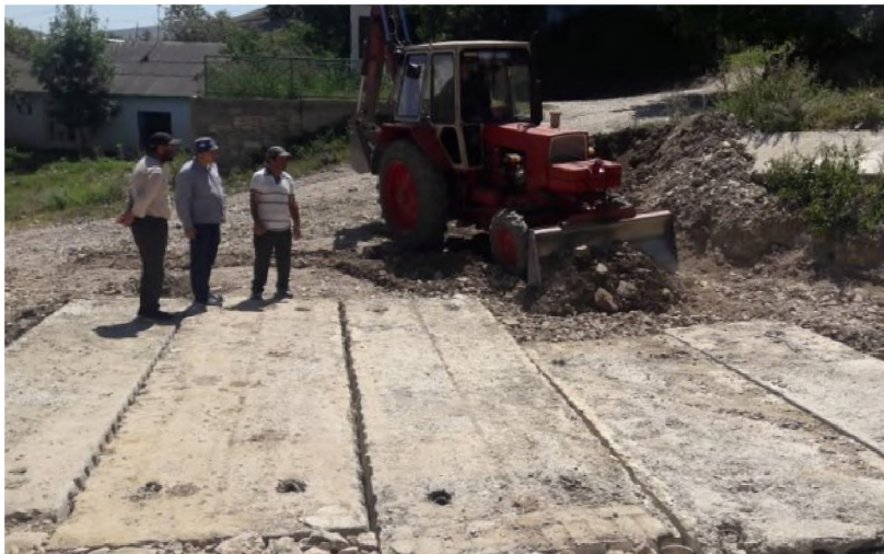
Два мостовых перехода в с. Аркас, разрушенные в результате схода селевого потока в 2016 году, восстановлены. Переходы про-
