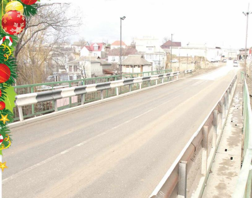
Завершилось возведение нового моста взамен разрушившегося, ведущего в сс. В. и Н. Казанище. Уложено асфальтное покрытие, с обеих сторон предусмотрены пешеходные дорожки, вдоль всего сооружения установлено освещение.
