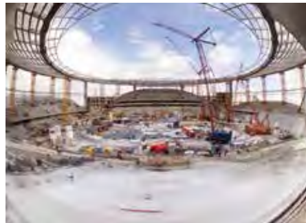
Центральный стадион после реконструкции был переименован в «Екатеринбург Арена»
