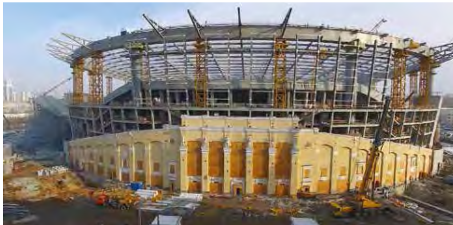
Перед строителями «Екатеринбург Арены» стояла непростая задача уместить новую чашу стадиона в пределах конструкций Центрального стадиона, имеющих историческую ценность
