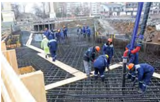
Рабочие заливают бетон
