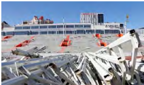
Общий вид Центрального стадиона
