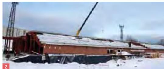
На площадке спортивно-оздоровительного комплекса «Калининец» в полном объеме проведены работы по ограждению стройплощадки, сносу трибун, демонтажу других конструкций, укреплению фундамента. Ведутся работы по подготовке основания и устройства дренажа футбольного поля, возведению каркаса здания, устройству наружных сетей.
